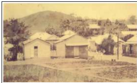
Foto 4: Plaza de Recreo, 1930 Fuente: Municipio de Trujillo Alto
